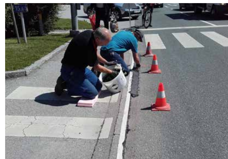
Kleinere und größere Straßenarbeiten gehören ebenso zum Aufgabengebiet des Bauhofs wie...
